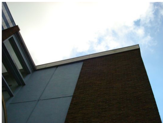
Holle ruimten met mogelijk vleermuisverblijfplaatsen
